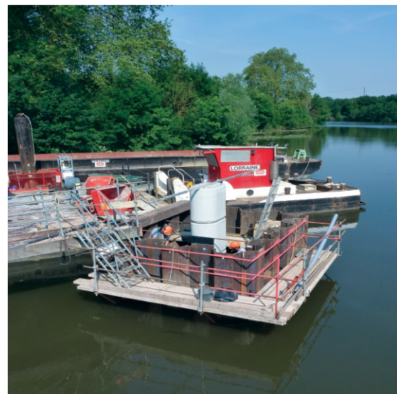
Contrôle des travaux de reconstruction et d'automatisation du barrage d'Apremont : pose d'une pile de la future passerelle technique.
