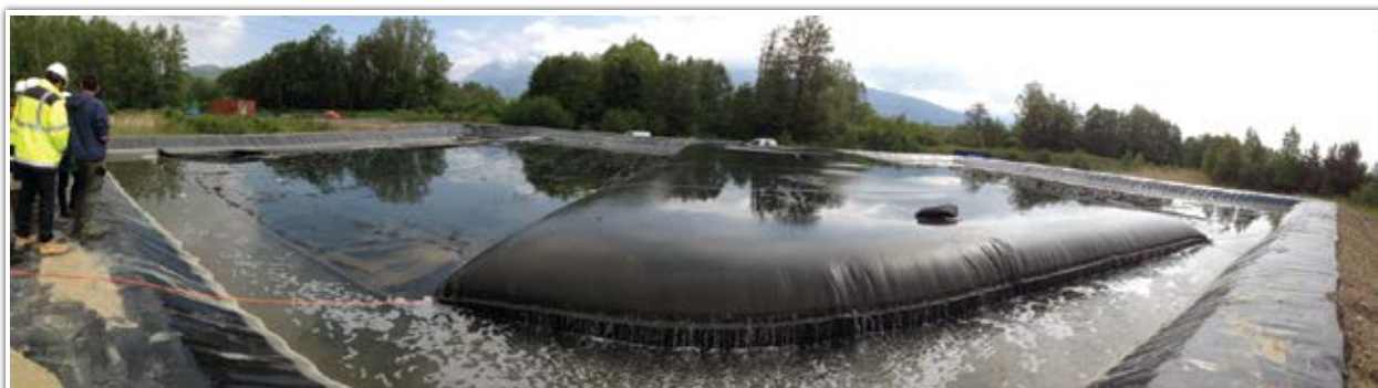
Essorage des sédiments dans une des poches textiles disposées sur le bassin étanche (©BRGM)
