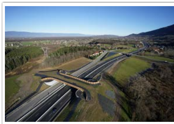
Écopont de Saint-Cergues permettant le passage de la faune, réalisé sur la RD 1206 dans le cadre de l'opération Chasseurs-Machilly
