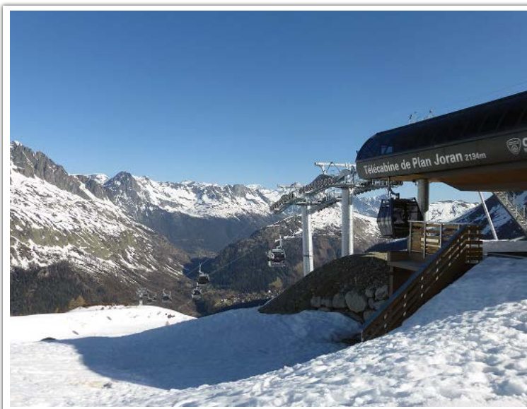
Site classé du massif du Mont Blanc – la télécabine de Plan Joran
