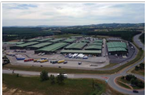
Extension de la société SNF, site chimique classé SEVESO seuil haut
