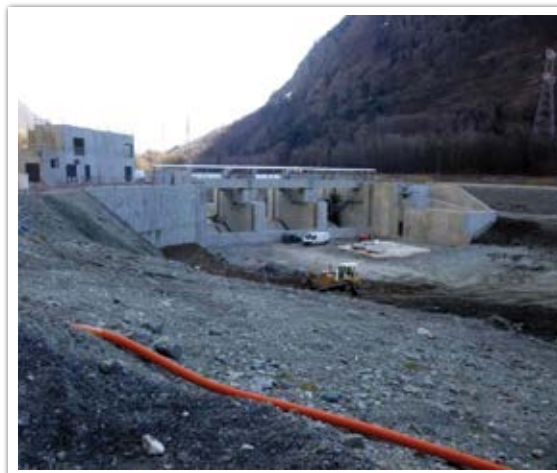
Construction du barrage de Romanche-Gavet
