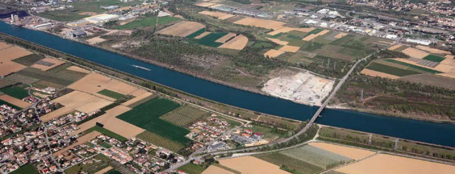
Vue aérienne sur le port public de Salaise-Sablons et le projet INSPIRA depuis la rive droite du Rhône © DREAL RA
