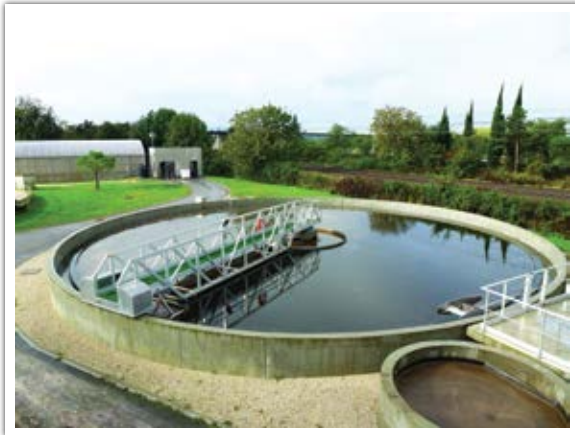
Station de traitement des eaux résiduaires urbaines (Livron, 26)
