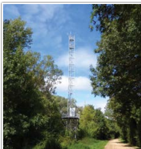
Antenne construite sans autorisation spéciale en site classé du Val de Saône
