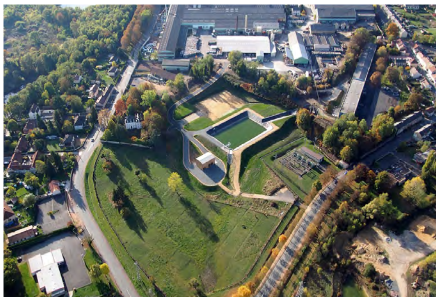
Station d'épuration des effluents Erasteel, mise en service fin 2016 - Site Acierie Erasteel
