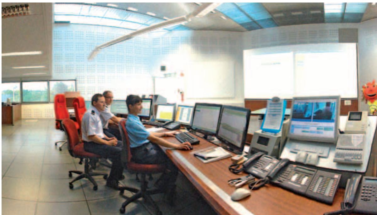
Cellule de crise - salle d'exploitation.
