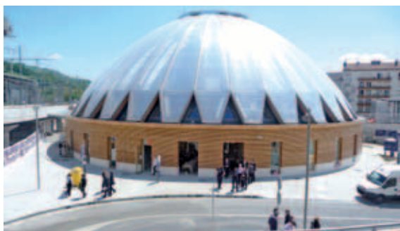
La nouvelle gare de Bellegarde-sur-Valsérine.
