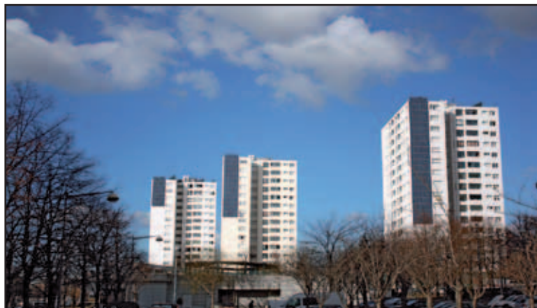
Panneaux solaires en façades sur des bâtiments à Vénissieux (69).
