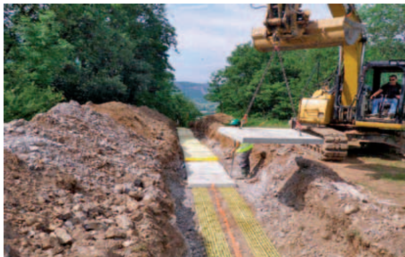
Pose de protection mécanique sur une canalisation d'éthylène.
