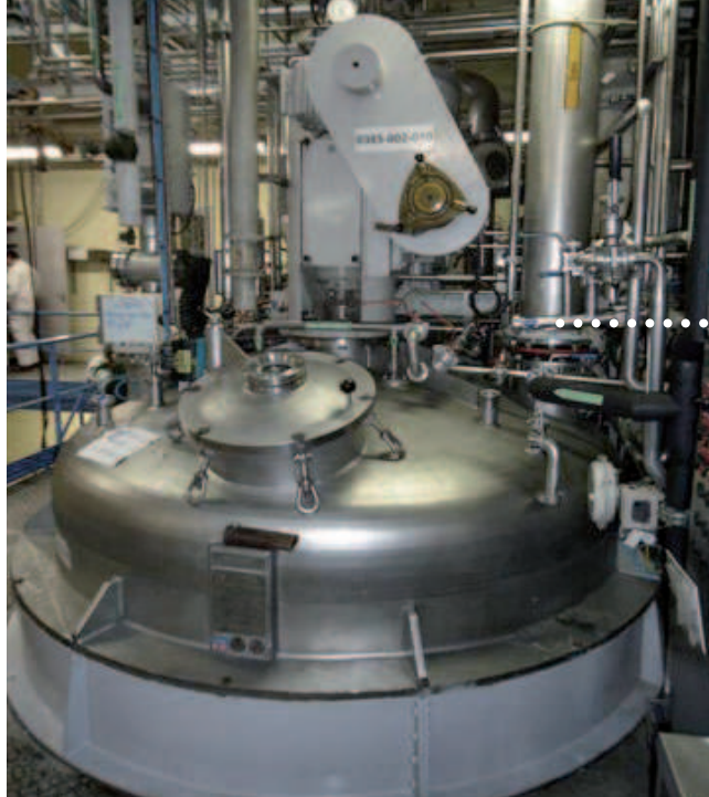
équipement sous pression : réacteur SANOFI
