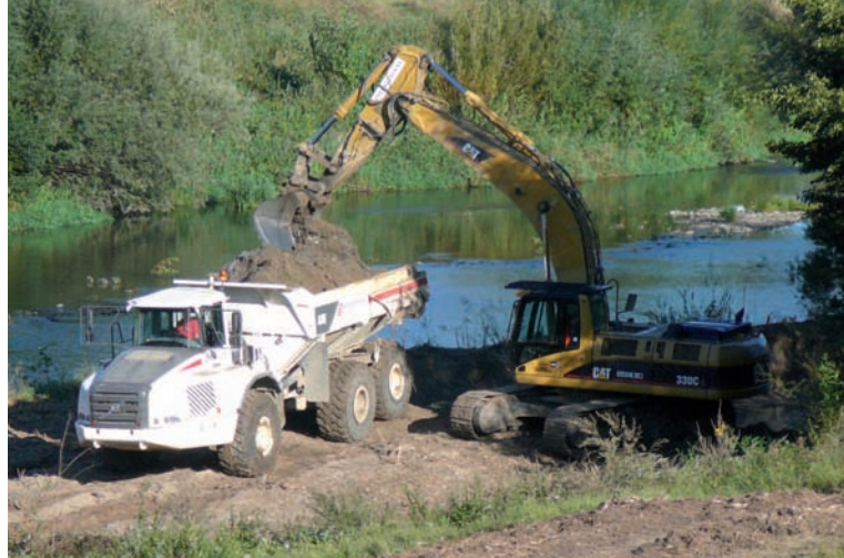
Travaux préparatoires à l'installation du batardeau - Le Puy-en-Velay
