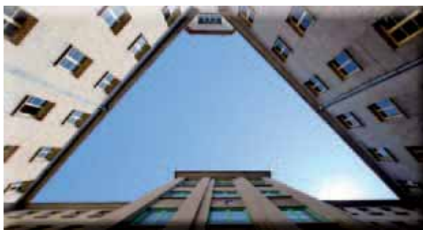
Cour intérieure du bâtiment de la DDT69 rue Moncey.
