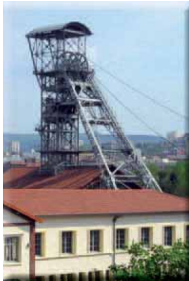
Le puits Couriot à St-Etienne (Loire).
