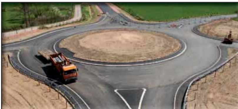
Le chantier de la déviation de Changy - La Pacaudière dans la Loire.
