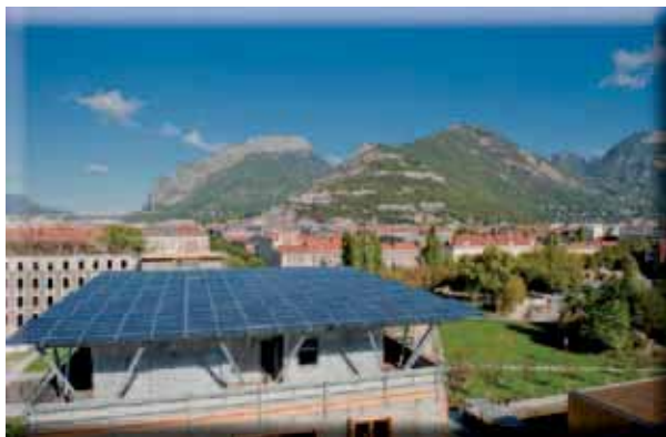
Centrale solaire photovoltaïque d'un bâtiment à énergie positive - Grenoble.
