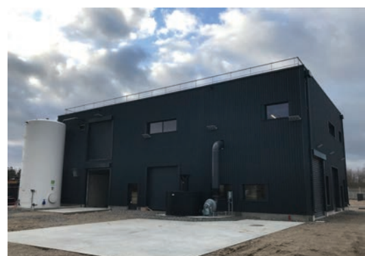
Bâtiment abritant la station de traitement
