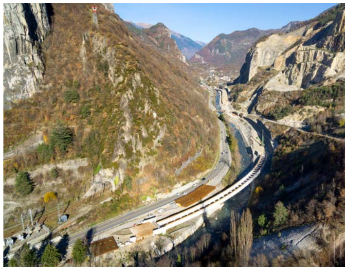
Vue aérienne du chantier de la RN90 Montgalgan (Savoie)
