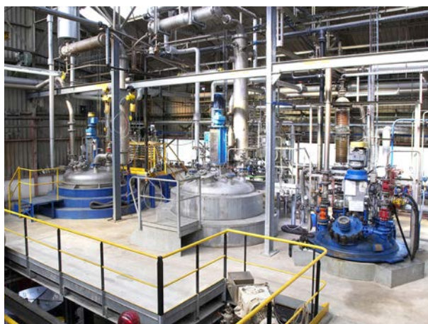
Usine ALL'CHEM de Montluçon (03)
