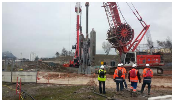
Outil de forage utilisé pour la paroi périmétrique
