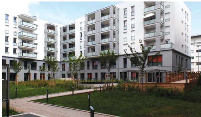
Résidence l'Odyssée à Bron (69) - Crédit photo "Amallia - Action Logement"
