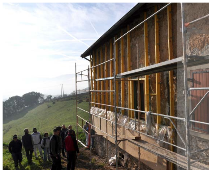
Rénovation BBC d'une ferme en pisé à Brullioles (69) – crédit photo "Parc Eco Habitat"
