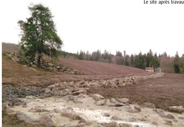
Le site après travaux
