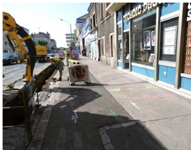
Repérage au sol de canalisations présentes sous un trottoir
