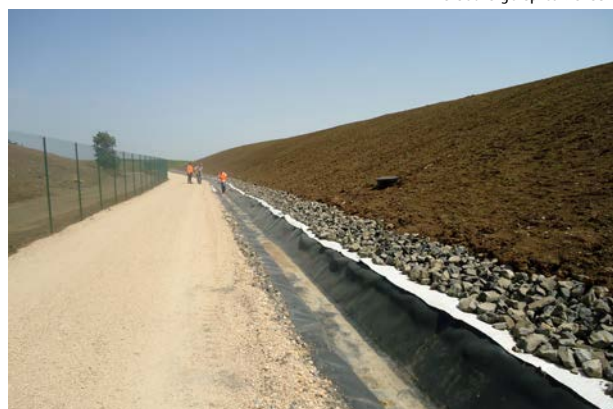
La décharge après travaux
