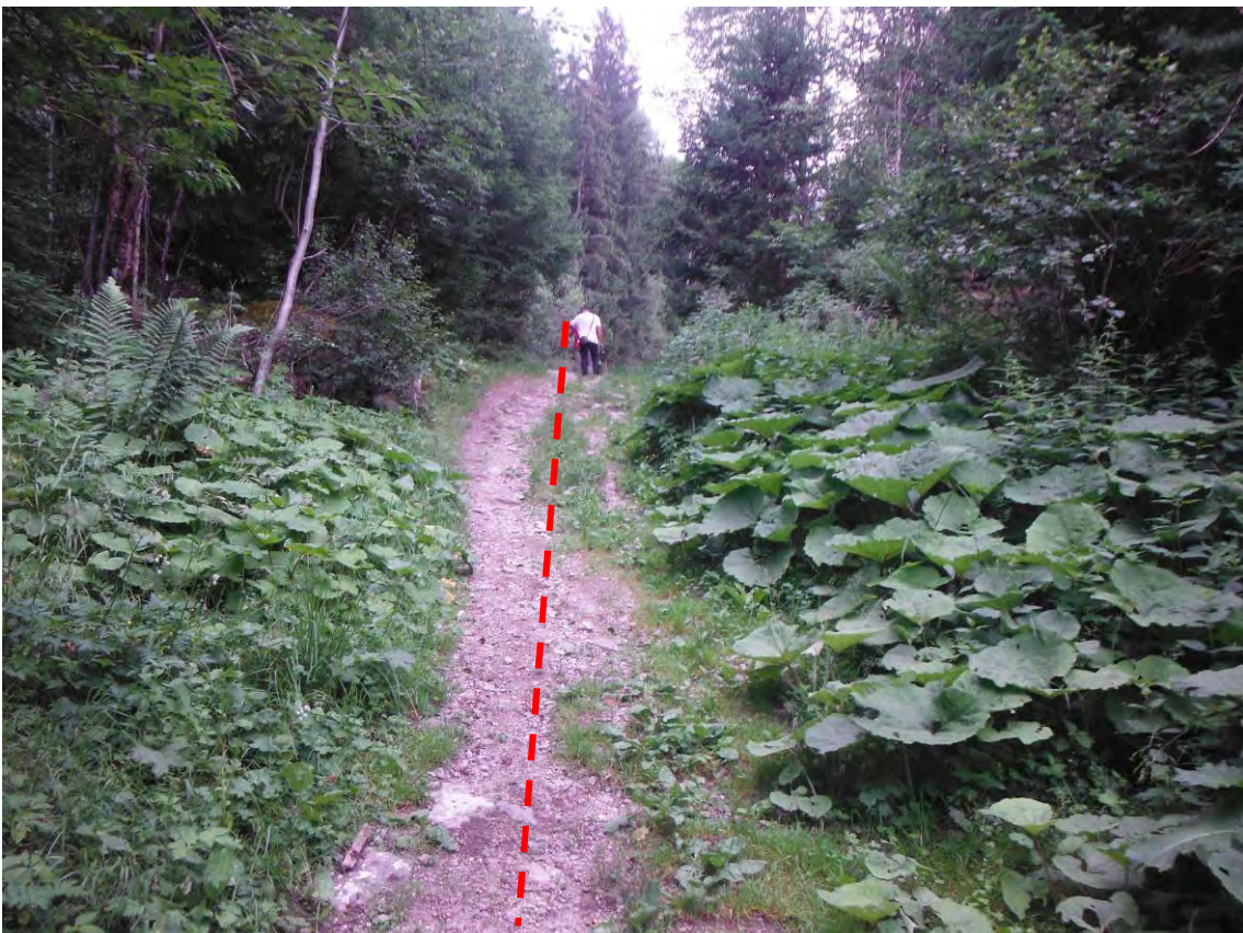
Photo D : Passage de la conduite forcée sous le chemin de promenade (27/06/2017)
