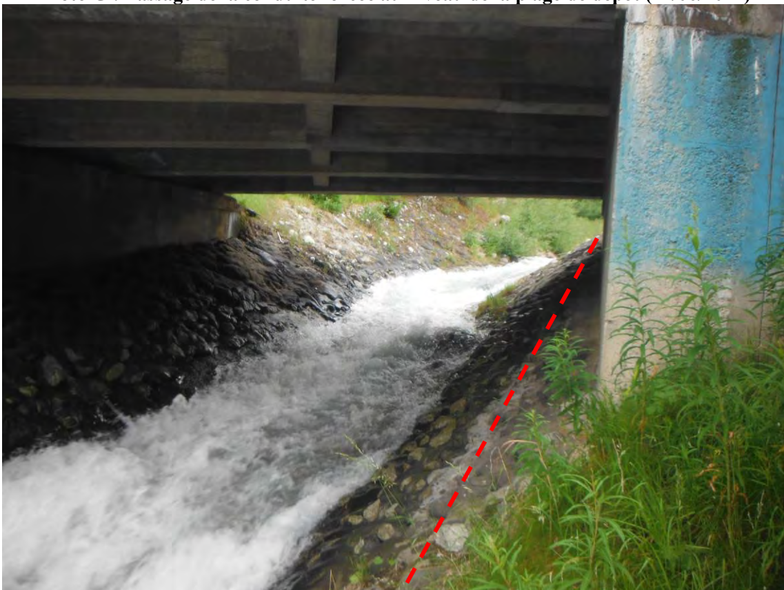
Photo H : Passage de la conduite forcée sous le tablier du pont de la RN 205 (27/06/2017)
