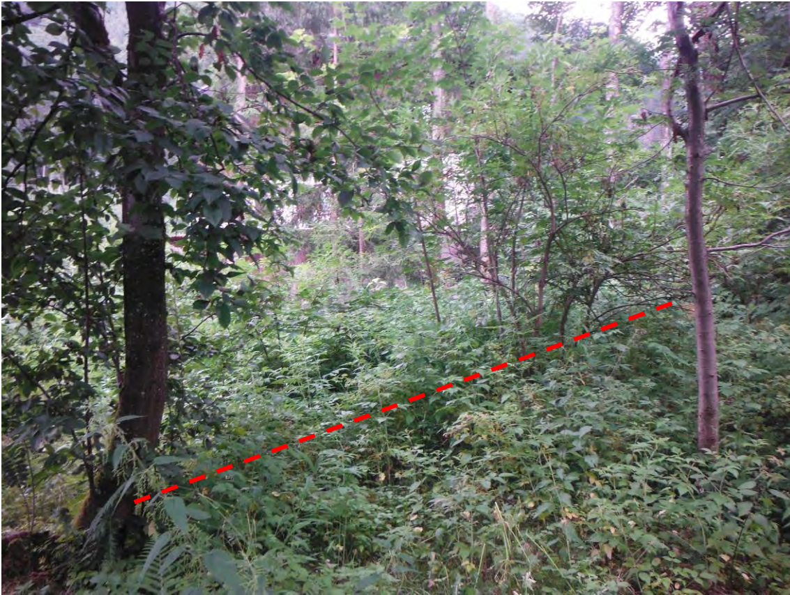
Photo O : Passage de la conduite forcée en rive droite en pied de digue (27/06/2017)
