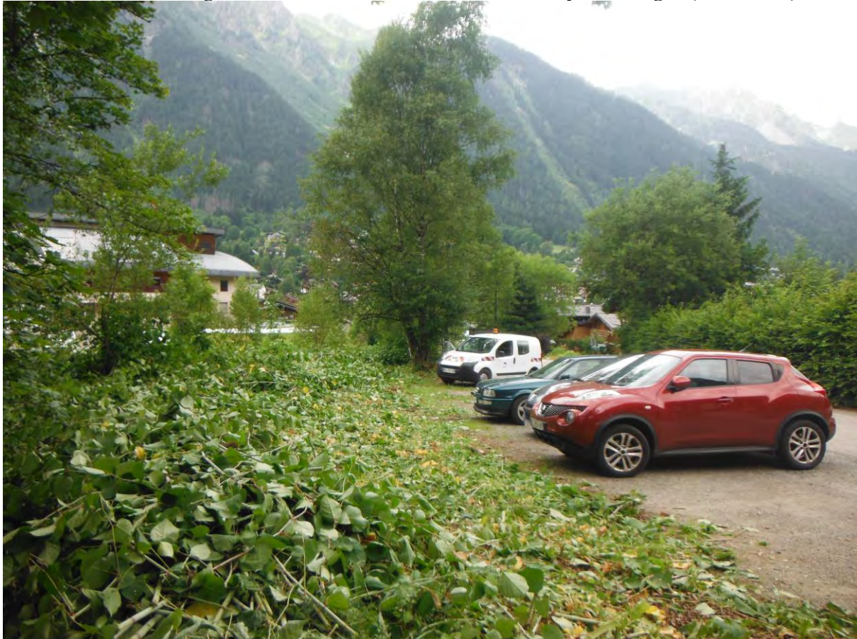
Photo P : Photo de l'emplacement de la future centrale (27/06/2017)
