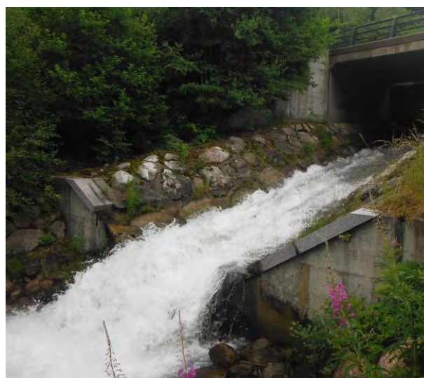
Seuil du pont de la N205
