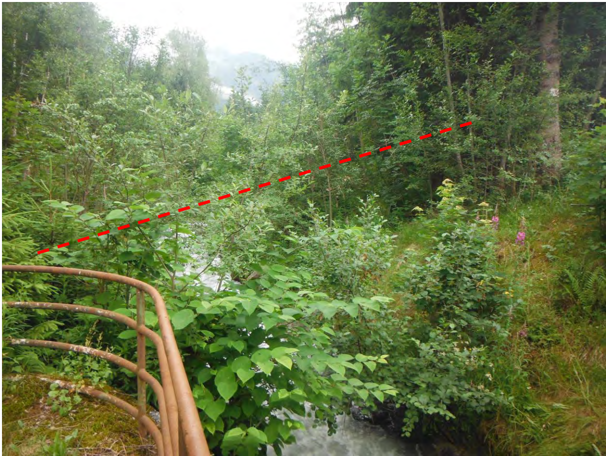
Photo M : Passage de la conduite forcée en rive droite en amont de la RN506 (27/06/2017)
