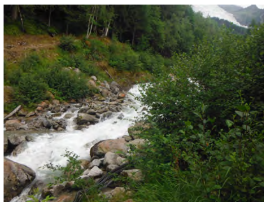
Vue des tuyaux acheminant l'eau à la plate forme
