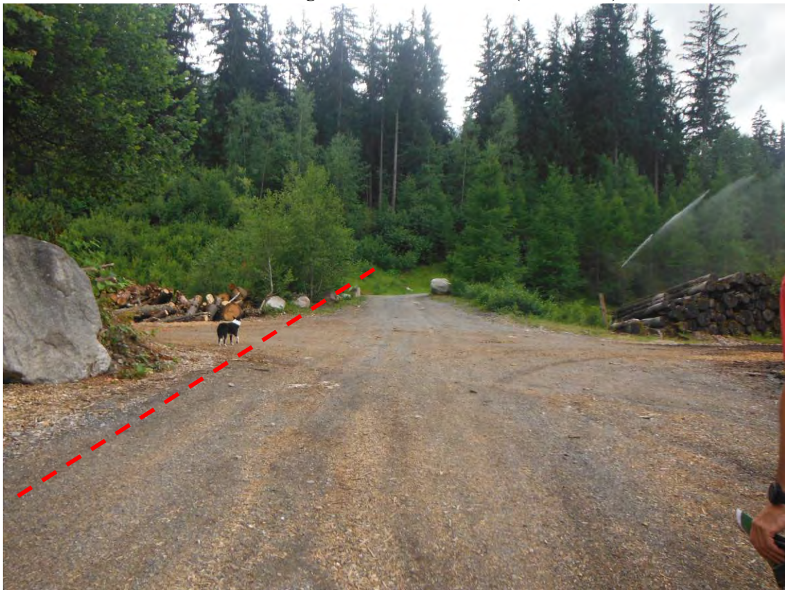
Photo F : Passage de la conduite au niveau de la plate forme ONF (27/06/2017)
