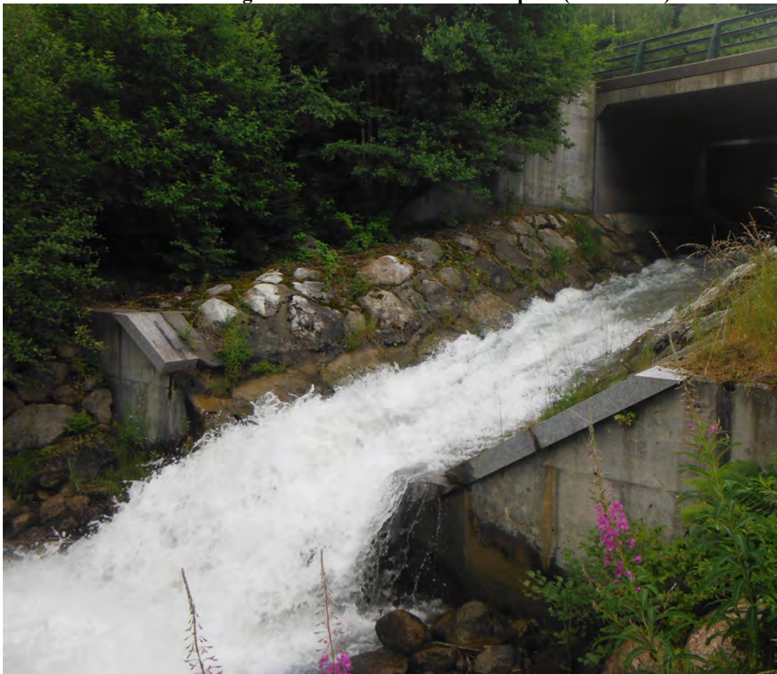
Photo J : Passage de la conduite forcée sous le pont de la RN205(27/06/2017)
