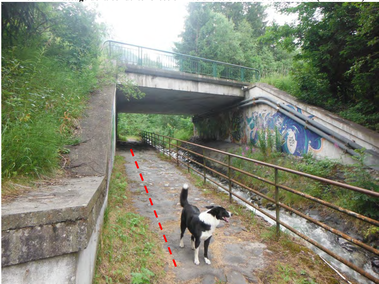
Photo N : Passage de la conduite forcée sous la passerelle du pont de la RN506 (27/06/2017)
