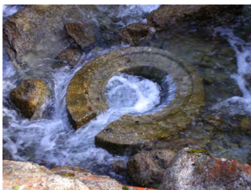
Vue de l'aménagement fixe dans le torrent
