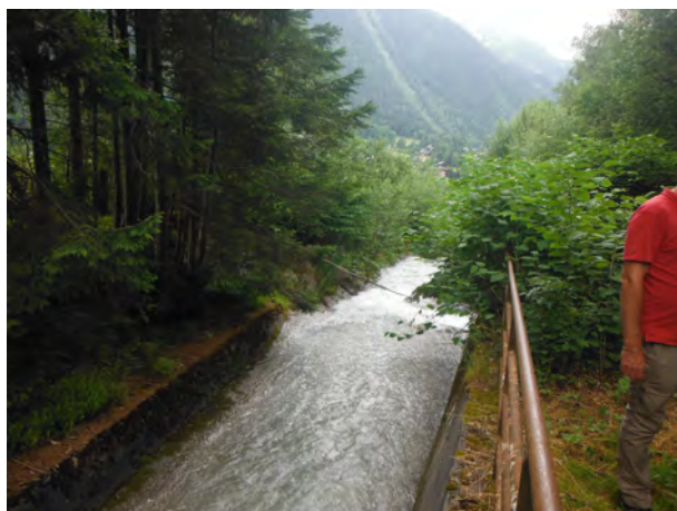
Radier bétonné sous la passerelle de la RN 206
