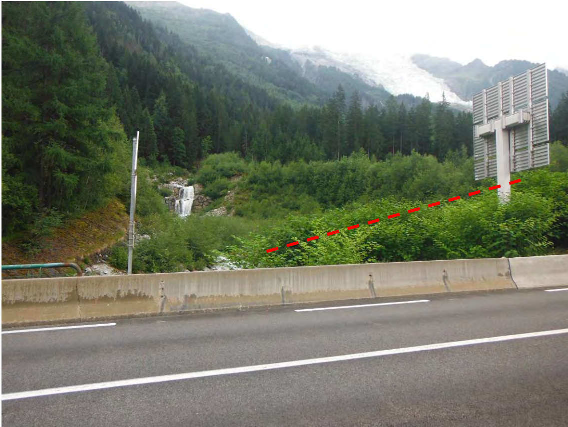
Photo G : Passage de la conduite forcée au niveau de la plage de dépôt (27/06/2017)
